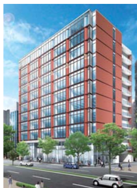
栄4丁目プロジェクト (名古屋市中区)建設中
