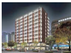
栄4丁目プロジェクト (名古屋市中区)建設中
